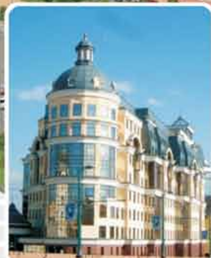
Здание Московского Банка
